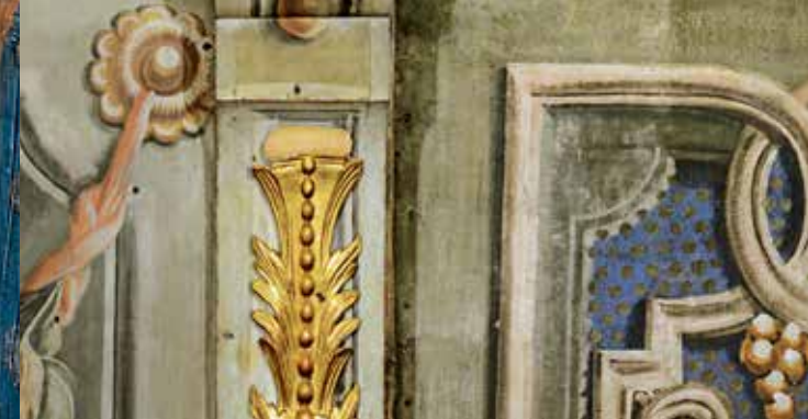
Logenbrüstung mit originaler Farbigkeit nach Abnahme der Übermalungen
