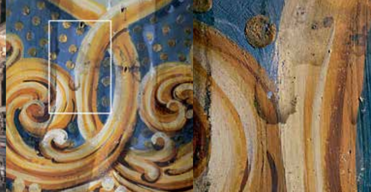
Befund der originalen Farbigkeit unter dem Balkon der nördlichen Trompeterloge
