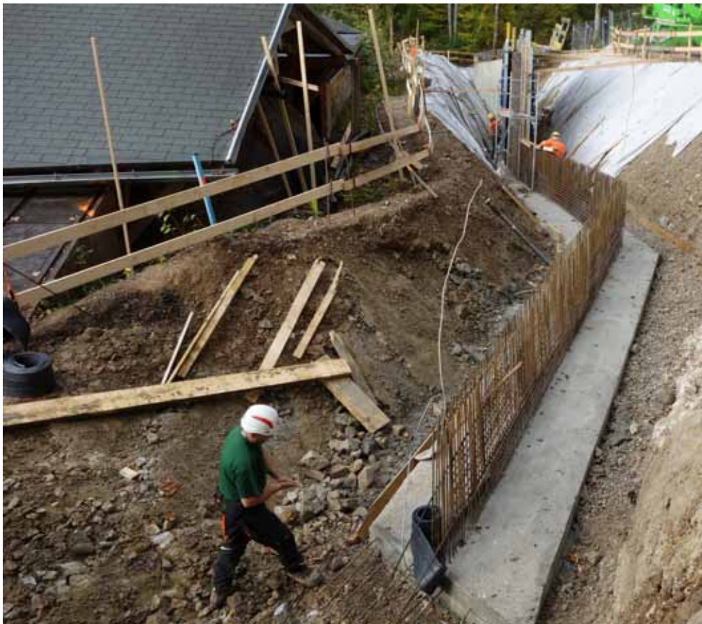
Venusgrotte, Bau einer unterirdischen Sperrmauer, 2015
