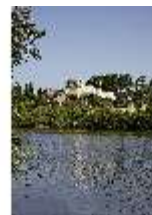
AschPomp.I, Süd- und Ostfassade, DI014988, BSV-
