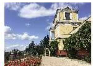
AschPomp.I, Fassade von Südosten, DI014979, BSV-
