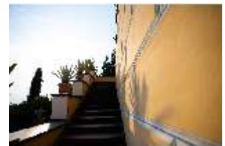
Aschpomp.I, Treppenaufgang im S zum OG, DI024868, BSV-
