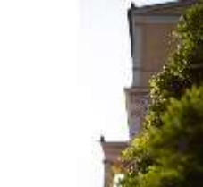
Aschpomp.V, Seitenblick auf Fassade, DI024852, BSV-
