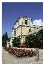
AschPomp.I, Fassade von Südosten, DI014977, BSV-
