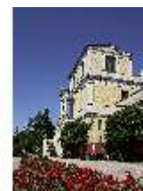
AschPomp.I, Fassade von Südosten, DI014978, BSV-
