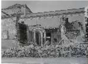
AschPomp.I, Hof nach Kriegszerstörung, DI033030, BSV-
