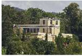
AschPomp.I, Pompejanum von Südwesten, DI014997, BSV-
