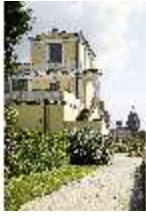
AschPomp.I, Fassade von Süd-Westen, DI014970, BSV-
