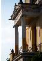
Aschpomp.I, Altane an der Südfassade, DI024862, BSV-
