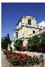
AschPomp.I, Fassade von Südosten, DI014976, BSV-
