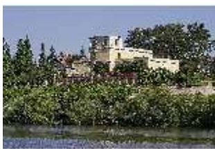
AschPomp.I, Süd- und Ostfassade, DI014989, BSV-
