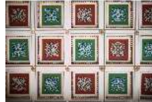
Aschpomp.II, Decke im Atrium, R. 2, DI024783, BSV-
