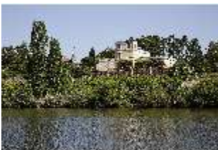
AschPomp.I, Südfassade vom Main aus, DI014981, BSV-
