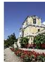
AschPomp.I, Fassade von Südosten, DI014975, BSV-
