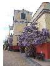
Aschpomp.I, Fassade von Südosten, DI022669, BSV-
