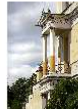
AschPomp.I, Südfassade mit Außentreppe und Aussichtspavillon, DI014974, RSV-
