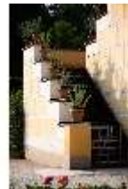
Aschpomp.I, Treppenaufgang im S zum OG, DI024864, BSV-
