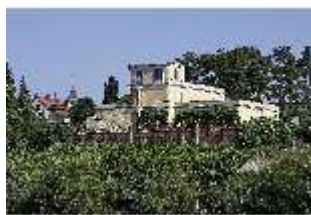
AschPomp.I, Süd- und Ostfassade, DI014990, BSV-
