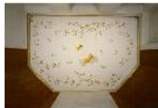
BayNS.II, Kommunikation, Ruhezimmer (R.30), Decke, DE002445, BSV
