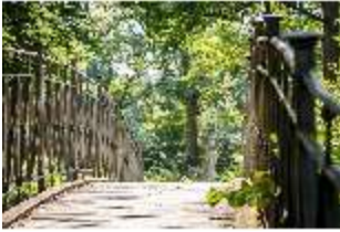
BayNS.V, Brücke über den Kanal, DI008436, BSV-
