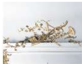
BayNS.II, Deckenstuckdet., Tri- angel, R.1.14, DE001814, BSV-
