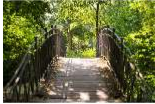
BayNS.V, Brücke zur Großen Insel, DI019879, BSV
