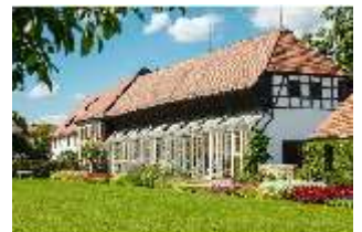
BayNS.V, Orangerie und ehemaliges Gärtnerhaus, DI008503, BSV-
