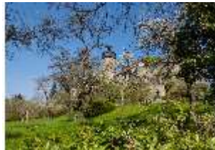
SaZwe.I, Fassade von Süd-Osten, DI007813, BSV-
