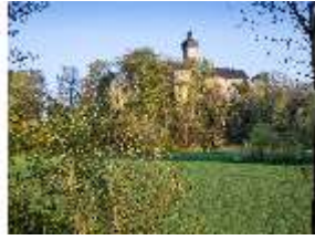
SaZwe.I, Blick auf die Nord-West Fassade, DI007931, BSV-
