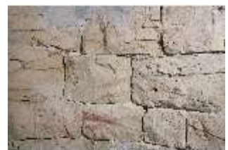
SaZwe.I, Mauerwerk im Bergfried (Detail), DI008221, BSV-
