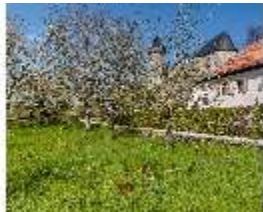
SaZwe.I, Fassade von Süd-Osten, DI007816, BSV-
