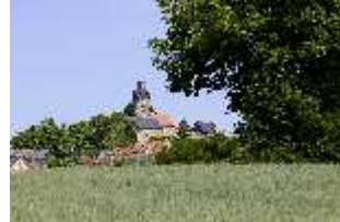
SaZwe.I, Burgfassade von SW mit Baum, DI037738, BSV-
