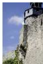
SaZwe.I, Südliche Vorburg mit Ringmauer, Blick hoch zum Bergfried, DI008210, BSV-
