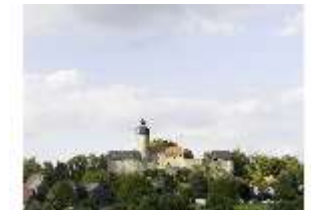
SaZwe.I, Burgfassade, Blick von Süden, DI008240, BSV-
