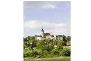
SaZwe.I, Burgfassade, Blick von Süden, DI008239, BSV-
