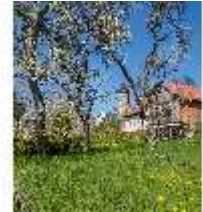
SaZwe.I, Fassade von Süd-Osten, DI007815, BSV-
