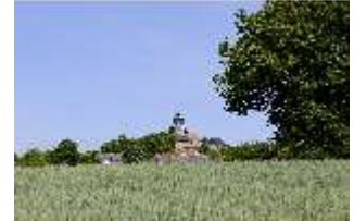
SaZwe.I, Burgfassade von SW mit Baum, DI037739, BSV-
