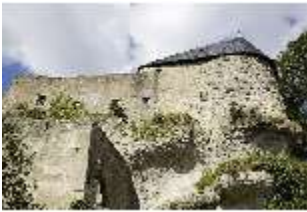
SaZwe.I, Unteres Tor, Wehrmauer vom Schönhof und Archivbau, DI008232, BSV-
