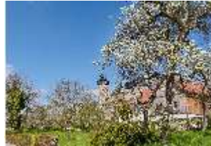
SaZwe.I, Fassade von Süd-Osten, DI007808, BSV-
