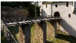
Pr.I, Nordfassade, Brücke, Luftaufnahme, DI034803, BSV-
