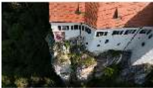
Pr.I, Südfassade, Luftaufnahme, Vogelperspektive, DI034797, RSV-
