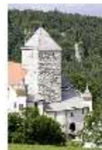
Pr.I, Torbau und Bergfried, Blick von Nordosten, DI001143, BSV
