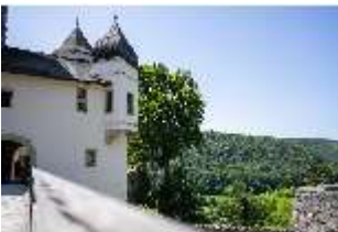
Pr.V, Erker, Nord/West-Ecke, Außenbereich, DI034912, BSV-
