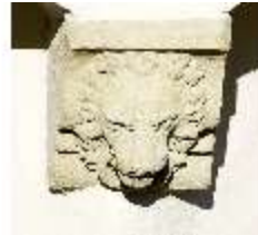
Pr.I, Erker, mittlere Konsole, Nordostseite, DI001159, BSV
