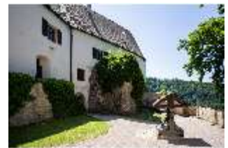
Pr.V, Hof, Außenbereich, Sommer, DI034931, BSV-
