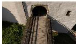
Pr.I, Nordfassade, Brücke, Luftaufnahme, DI034806, BSV-
