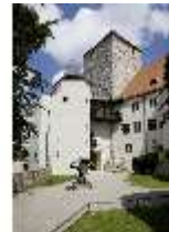
Pr.I, Innenhof, Ziehbrunnen und Torbau, DI001139, BSV
