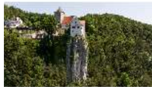
Pr.I, Westfassade, Jurakalkfelsen, Blick von Westen, Luftaufnahme, DI034813, BSV-
