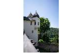
Pr.V, Erker, Nord/West-Ecke, Außenbereich, DI034911, BSV-
