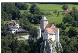
Pr.I, Blick von Südenwesten, DI001153, BSV
