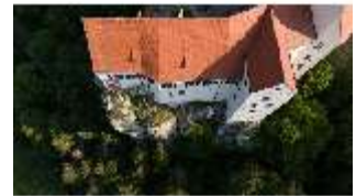
Pr.I, Südfassade, Luftaufnahme, Vogelperspektive, DI034796, RSV-
