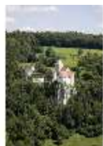
Pr.I, Blick von Südenwesten, DI001154, BSV
