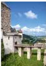
Pr.I, Teil der Brücke, im MA als Zugbrücke genutzt, DI021078, BSV
