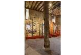
Pr.II, Palas mit Stützenkonstruktion, Raum 2, 1. OG, DI021062, BSV
