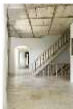
Pr.II, Treppenhaus, R.7, DI001172, BSV
