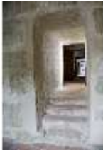
Pr.II, Bergfried, Durchgang, DI001196, BSV
