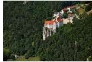
Pr.I, Burg Prunn, Luftaufnahme, DI023901, BSV
