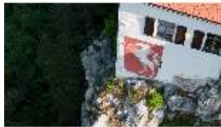
Pr.I, Südfassade, Luftaufnahme, Vogelperspektive, DI034798, RSV-
