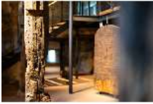
Pr.II, Eichenstütze und Bergfriedtür, Palas, R. 2, DI034834, BSV-
