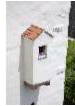
Pr.I, Südfassade, ehem. Abtritt, DI001128, BSV
