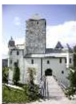
Pr.I, Nordfassade, Torbau und Bergfried, DI001140, BSV
