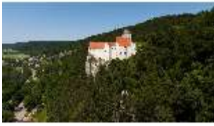
Pr.I, Südfassade, Blick von Süd/Ost, Altmühltal, Luftaufnahme, DI034811, RSV-
