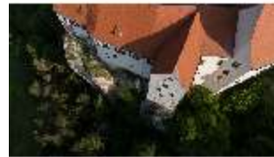
Pr.I, Südfassade, Luftaufnahme, Vogelperspektive, DI034795, RSV-
