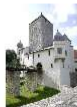
Pr.I, Nordfassade, Schrägensicht, DI001141, BSV
