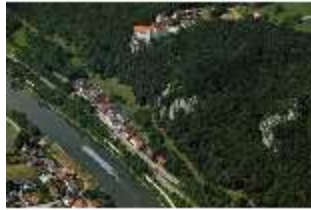
Pr.I, Burg Prunn, Luftaufnahme, DI023900, BSV
