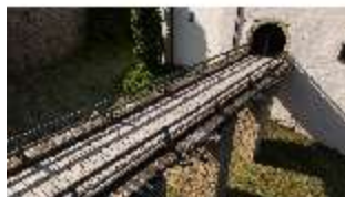
Pr.I, Nordfassade, Brücke, Luftaufnahme, DI034804, BSV-
