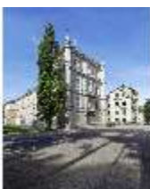
CoE.I, Seitentrakte der Hauptfassade, DI009206, BSV-
