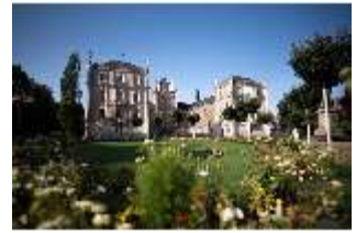
CoE.I, Hauptfassade vom Schlossplatz aus, DI025108, BSV-
