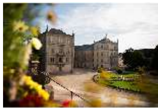
CoE.I, Hauptfassade des Schlosses (vom Hofgarten aus), DI024930, BSV-
