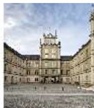
CoE.I, Hauptfassade und Ehrenhof, DI009197, BSV-
