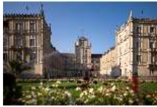
CoE.I, Hauptfassade vom Schlossplatz aus, DI025112, BSV-
