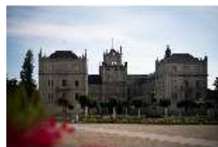
CoE.I, Hauptfassade und Schlossplatz von Norden, DI024911, BSV-
