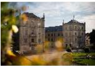
CoE.I, Hauptfassade des Schlosses (vom Hofgarten aus), DI024929, BSV-
