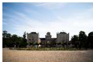
CoE.I, Hauptfassade und Schlossplatz von Norden, DI024910, BSV-
