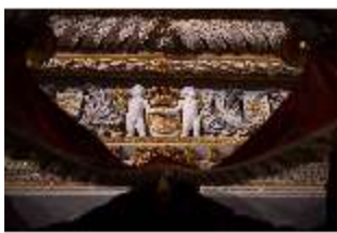
CoE.II, Thronsaal, R. 13, Deckendetail: Hohlkehle, DI024996, BSV-
