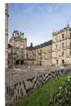
CoE.I, Hauptfassade und Ehrenhof, DI009198, BSV-
