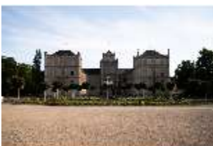
CoE.I, Hauptfassade und Schlossplatz von Norden, DI024909, BSV-
