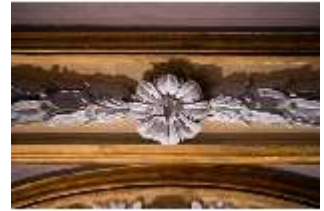
CoE.II, Audienzzimmer, Stuckleisten an der Decke, DI025041, BSV-
