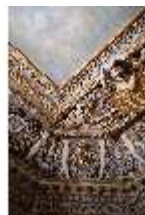
CoE.II, Thronsaal, R. 13, Deckendetail: Hohlkehle, DI024992, BSV-
