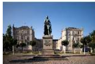
CoE.I, Hauptfassade, Schlossplatz, Denkmal von Ernst I., DI025111, BSV-
