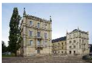
CoE.I, Seitentrakte der Hauptfassade, DI009199, BSV-
