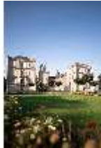
CoE.I, Hauptfassade vom Schlossplatz aus, DI025110, BSV-
