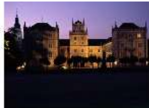
CoE.I, Hauptfassade am Ehrenhof, DE000140, BSV-
