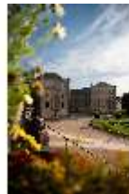
CoE.I, Hauptfassade des Schlosses (vom Hofgarten aus), DI024931, BSV-
