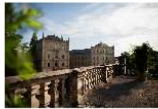
CoE.I, Hauptfassade des Schlosses, DI024927, BSV-
