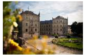
CoE.I, Hauptfassade des Schlosses (vom Hofgarten aus), DI024928, BSV-
