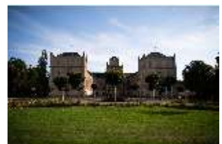
CoE.I, Hauptfassade und Schlossplatz von Norden, DI024912, BSV-
