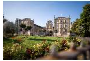
CoE.I, Hauptfassade vom Schlossplatz aus, DI025114, BSV-
