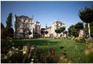
CoE.I, Hauptfassade vom Schlossplatz aus, DI025109, BSV-
