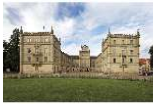
CoE.I, Hauptfassade, DI009196, BSV-
