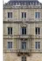
CoE.I, Hauptfassade, linker Trakt, DI009203, BSV-
