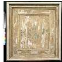
EiW.III,V, Teil der Kassettendecke, Botanische Treppe, DI000073, BSV
