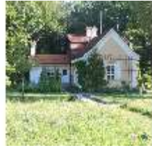
HoGast.I, Gasteigerhaus von Süden mit Küchenanbau, DI013109, BSV
