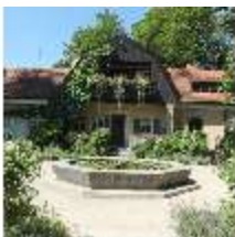
HoGast.I, Gasteigerhaus von Osten mit Seerosenbecken, DI013123, BSV
