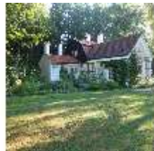
HoGast.I, Gasteigerhaus von Südwesten, DI013130, BSV
