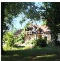
HoGast.I, Gasteigerhaus von Nordosten, DI013119, BSV
