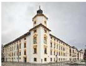
KemRes.I, Südwestlicher Eckturm, DI015611, BSV-
