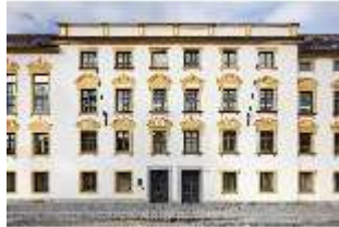
KemRes.I, Südfassade, Eingangsbereich, DI015610, BSV-
