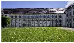
KemRes.I, Innenhof, Ostfassade, DI036322, BSV-
