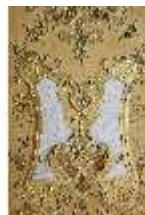
KemRes.II, Vorraum des Schlafzimmers, Stuckornament, DI036333, BSV-
