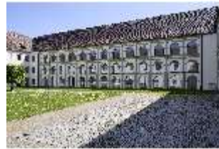
KemRes.I, Innenhof, Ostfassade, DI036323, BSV-
