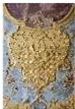
KemRes.II, Vorraum des Schlafzimmers, Stuckornament, DI036331, BSV-
