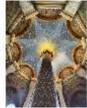
Neusch.II, Treppenturm/Treppenhaus, Kuppel, DI037426, BSV
