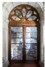
Neusch.II, Palas, 1. OG, Tür Haupttreppenhaus, DI016883, BSV-
