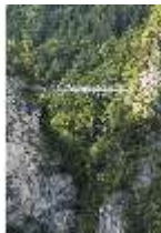
Neusch.I, Marienbrücke, DI033178, BSV-
