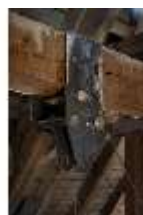
Neusch.II, Dachstuhl, DI017028, BSV-
