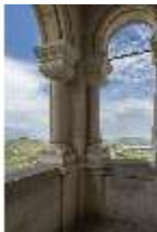
Neusch.I, Ausblick vom Söller Richtung Forggensee, DI033167, BSV-
