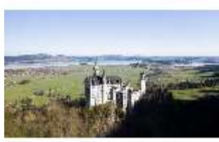
Neusch.I, Südansicht, DI016825, BSV-
