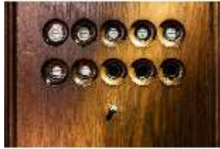
Neusch.II, elektrische Rufanlage, DI016899, BSV-
