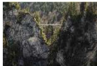
Neusch.I, Marienbrücke, DI016932, BSV-
