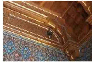
Neusch.II, Arbeitszimmer, Decke, DI016908, BSV-
