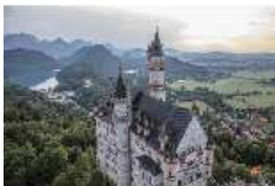
Neusch.I, Luftaufnahme, Treppenturm, DI010617, BSV
