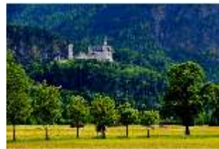
Neusch.I, Gesamtaufnahme der Nordfassade, DI006313, BSV-
