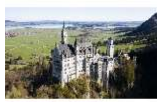
Neusch.I, Südansicht, DI016828, BSV-
