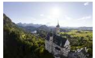
Neusch.I, Südansicht, DI016850, BSV-
