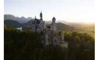
Neusch.I, Ostansicht, DI016845, BSV-
