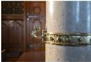
Neusch.III,V, Vorzimmer, R. 11, Vorhanghalterung, DI037177, BSV-
