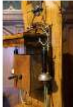
Neusch.II, Vorzimmer, Telefonanschluss, DI016912, BSV-
