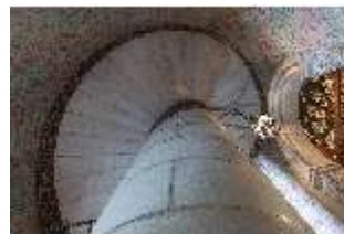
Neusch.II, Treppenturm/Treppenhaus, DI037252, BSV-
