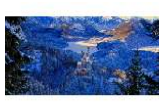
Neusch.I, Gesamtaufnahme der Ostfassade, verschneit, DI006312, BSV-
