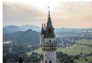
Neusch.I, Luftaufnahme, Treppenturm, DI010615, BSV
