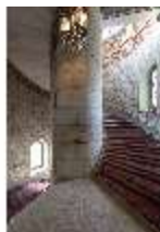
Neusch.II, Treppenturm/Treppenhaus, DI037254, BSV-
