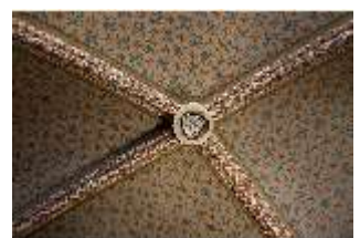
Neusch.II, Unterer Vorplatz, Gewölbe mit Wappen, R. 1, DI035894, BSV-
