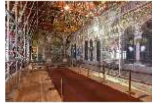
Neusch.II, Sängersaal, Sanierung 2018, DI013711, BSV-
