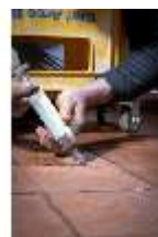
Neusch.II, Restaurierung und Instandhaltung, DI017062, BSV-
