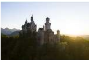
Neusch.I, Ostansicht, DI016846, BSV-
