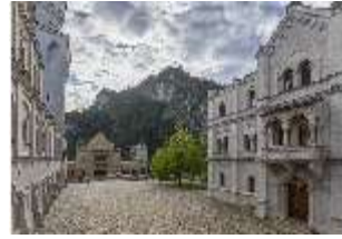
Neusch.I, Oberer Hof, Torbau und Kemenate, DI033165, BSV-
