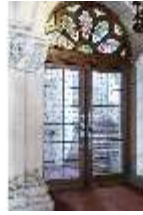
Neusch.II, Palas, 1. OG, Tür Haupttreppenhaus, DI016886, BSV-
