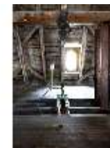
Neusch.II, Dachstuhl, DI017025, BSV-
