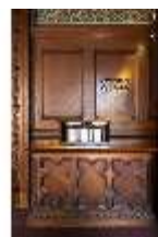
Neusch.II, Kammerdienerzi., elektr. Rufanlage, DI016898, BSV-
