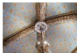
Neusch.II, Unterer Vorplatz, Gewölbe, DI035864, BSV-
