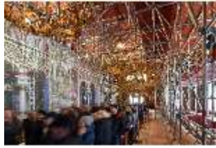
Neusch.II, Sängersaal, Sanierung 2018, DI013710, BSV-
