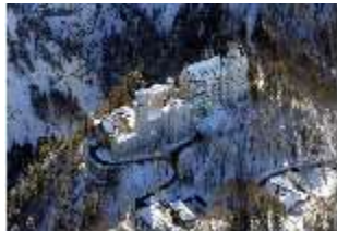
Neusch.I, Luftaufnahme, Blick nach Süd-Westen, DI002146, BSV
