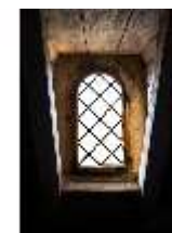
Neusch.II, Dachstuhl, DI017029, BSV-
