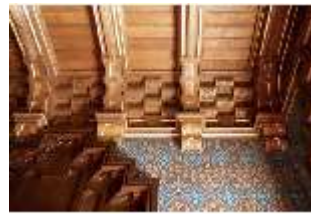
Neusch.II, Arbeitszimmer, Decke, DI016907, BSV-
