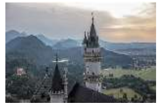
Neusch.I, Luftaufnahme, Treppenturm, DI010616, BSV
