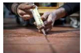
Neusch.II, Restaurierung und Instandhaltung, DI017063, BSV-
