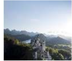
Neusch.I, Ostansicht, DI016841, BSV-
