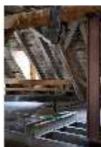
Neusch.II, Dachstuhl, DI017026, BSV-
