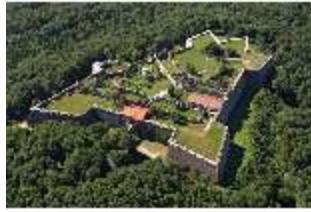
RoFg.I, Luftaufnahme, Blick von Nordosten, DI000217, BSV
