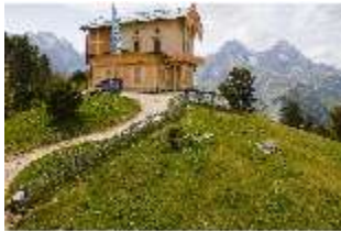
Scha.I, Königshaus Ostfassade, DI038735, BSV-
