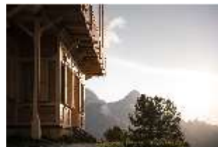
Scha.I, Detail Nordfassade, DI038794, BSV-
