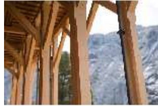
Scha.I, Träger, Balken, DI038771, BSV-
