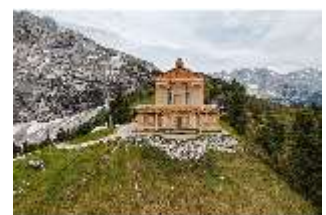
Scha.I, Königshaus Nordfassade, DI038725, BSV-
