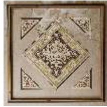
Scha.II, Zimmerdecke im Fremdenzimmer, DI006322, BSV-
