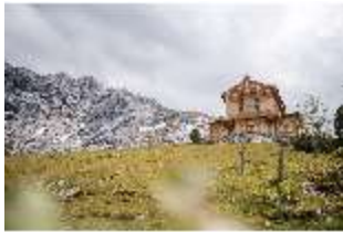
Scha.I, Königshaus Nordfassade, DI038788, BSV-
