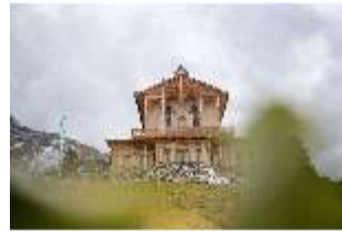
Scha.I, Königshaus Nordfassade, DI038790, BSV-
