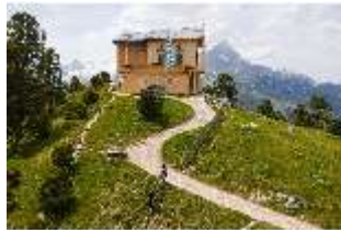
Scha.I, Königshaus Ostfassade, DI038736, BSV-
