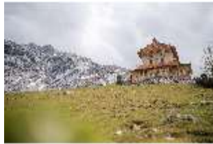
Scha.I, Königshaus Nordfassade, DI038789, BSV-
