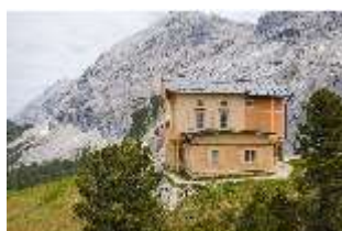
Scha.I, Königshaus Westfassade, DI038728, BSV-
