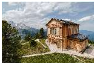
Scha.I, Königshaus Süd/Westfassade, DI038740, BSV-
