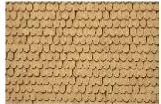
Scha.I, Außenwand, Detail Schindeln, DI033065, BSV-
