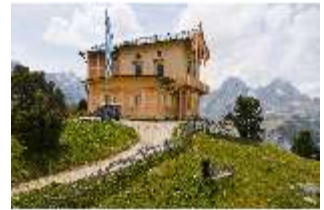
Scha.I, Königshaus Ostfassade, DI038734, BSV-
