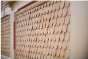
Scha.I, Außenwand, Schindeln, DI038770, BSV-
