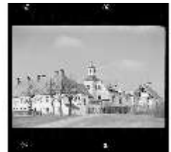
SAS.I, Kriegszerstörte Ostseite, DE000340, BSV
