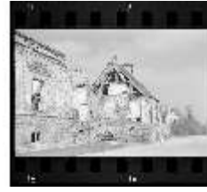
SAS.I, Kriegszerstörte Ostseite, DE000333, BSV
