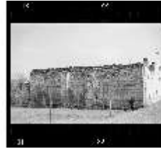
SAS.I, Kriegszerstörte Mauer, DE000341, BSV
