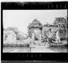
SAS.I, Kriegszerstörte Ostfassade (Detail), DE000318, BSV
