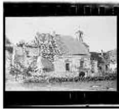
SAS.I, Kriegszerstörte Ostfassade (Detail), DE000319, BSV
