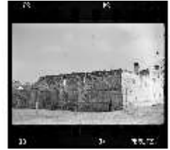
SAS.I, Kriegszerstörte Mauer, DE000342, BSV
