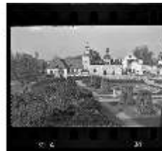
SAS.I, Kriegszerstörte Ostseite, DE000326, BSV
