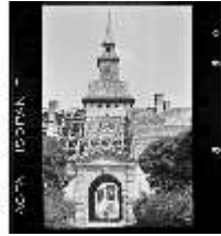
SAS.I, Kriegszerstörte Uhrenturm im Wiederaufbau, DE000343, BSV
