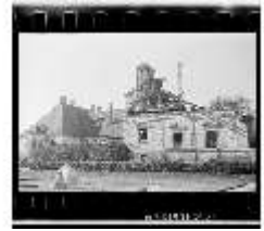
SAS.I, Kriegszerstörte Ostfassade (Detail), DE000317, BSV
