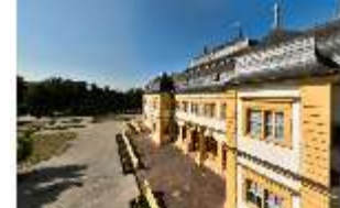
Vh.I, Westfassade, Schloss, Luftaufnahme von Süd/West, DI027522, BSV-
