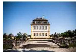
Vh.I, Südfassade und Südliche Treppenanlage, Schloss, DI027546, BSV-
