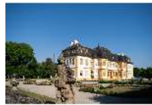
Vh.I, Ostfassade und Schlossterrasse, Schloss, DI027550, BSV-
