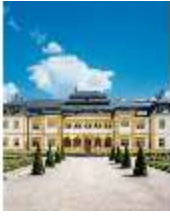
Vh.I, Westfassade, DE001287, BSV
