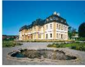
Vh.I, Westfassade, DE001540, BSV-
