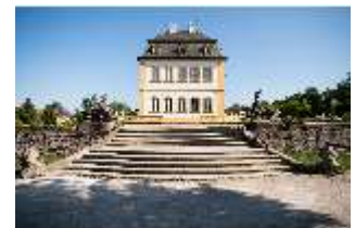
Vh.I, Südfassade und Südliche Treppenanlage, Schloss, DI027556, BSV-
