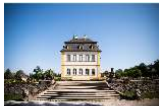
Vh.I, Südfassade und Südliche Treppenanlage, Schloss, DI027545, BSV-
