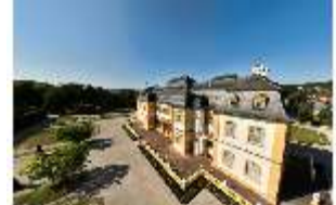
Vh.I, Westfassade, Schloss, Luftaufnahme von Süd/West, DI027521, BSV-
