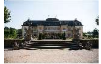
Vh.I, Westfassade und Westliche Treppenanlage, Schloss, DI027593, BSV-
