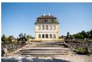
Vh.I, Südfassade und Südliche Treppenanlage, Schloss, DI027557, BSV-
