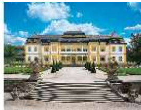
Vh.I, Hauptfassade, Westtreppe zum Parterre, DE002494, BSV
